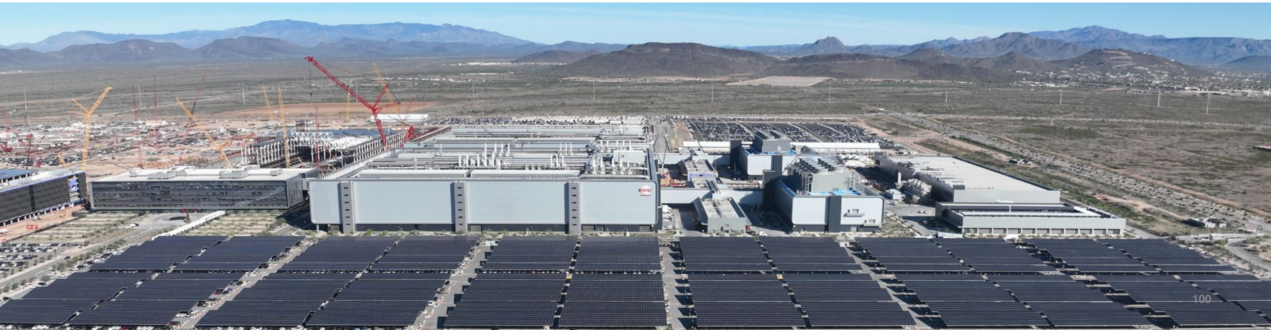
TSMC Arizona 廠區停車場太陽光電發電系統
